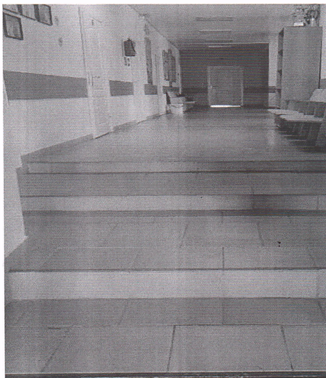
Фото 9 Лестница внутри здания
