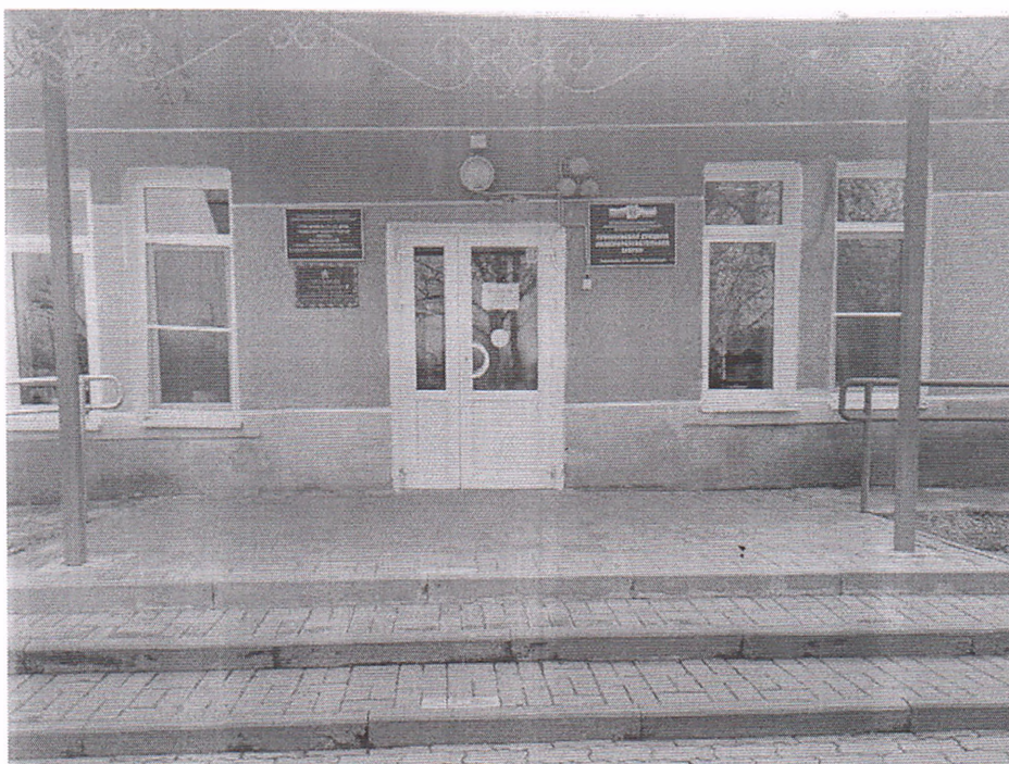
Фото №3 Лестница наружная
